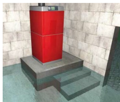
Mise hors d'eau par surélévation
