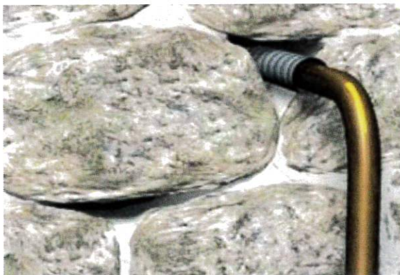
Situation initiale avant colmatage
