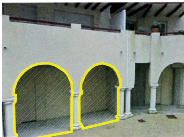
Obturation d'une travée de galerie
