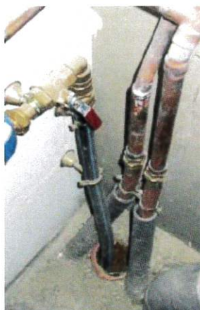
Exemple d'entrées de réseaux à calfeutrer
