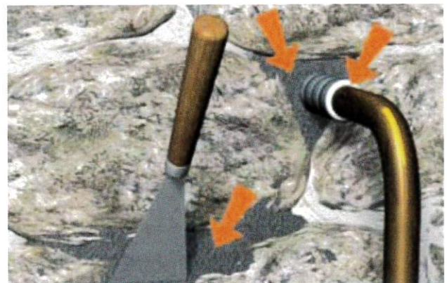
Situation après travaux de colmatage
